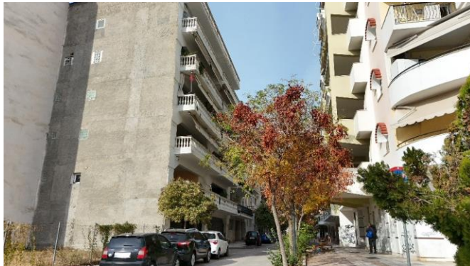
Οδός Στρυμόνος μετά την ανάπλαση
